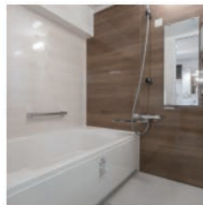
築30年を超えてくすんでいた浴室を、最新のものに
